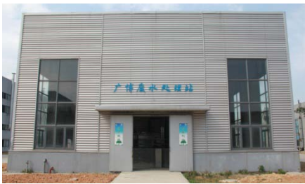
广博废水处理站外景
